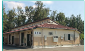
小規模校区に建設した町営住宅
