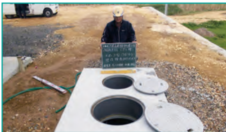
浄化槽の設置
