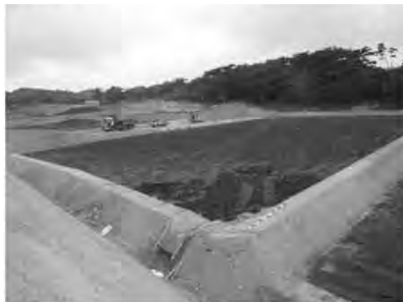
現在、進行中の畑総現場（第一面縄一期地区）
