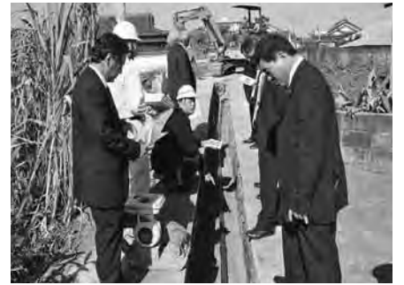
小島地区の水道管敷設事業
