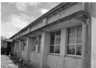
阿三集落にある袖センター跡。隣接する町営住宅も老朽化が進み、現在居住している住民にとっても厳しい生活環境を強いられている。
