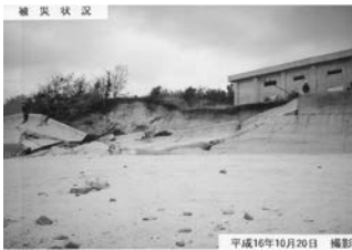
平成16年の台風災害における被災状況。町内集落の低地に居住する住民にとっては自然災害発生時の安全な避難場所の指定が急務である。
