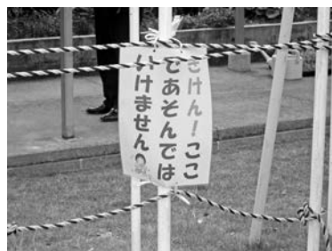
せっかくの遊具も張紙がされ、一刻も早い修繕が必要である。
