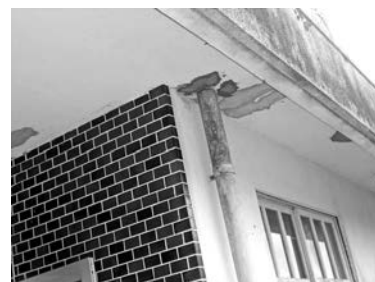
小規模学校の至る所で施設の老朽化が進んでいる。
