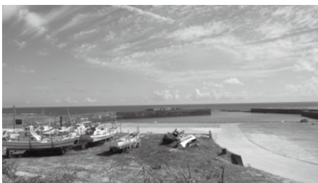
漁業集落の活性化や防災等にも配慮した港湾整備を行うことで、販売面や地域資源である漁場の生産性の向上が期待される。(写真：面縄港)
