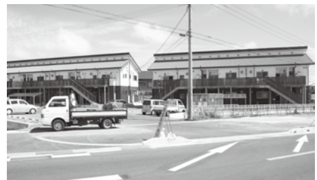
県道と隣接する亀戸住宅。撮影時にも子供たちが駐車場と反対方面の道を往来し、車のドライバーも住民も注意が必要な状況である。(写真：亀戸住宅)
