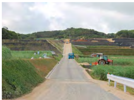
第二面縄1期地区土地改良現場
