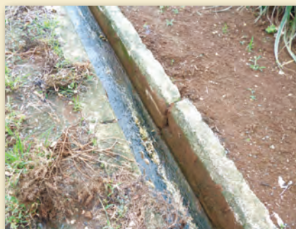
排水路のコンクリート壁が一部決壊
