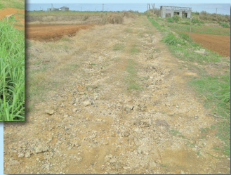
雨によりコーラルが洗掘 (面縄地区)
