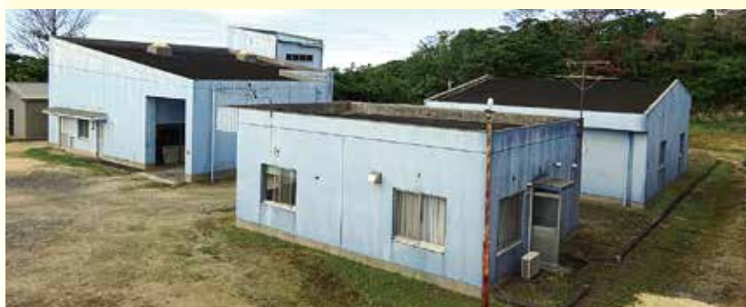
伊仙町有機物供給センター
