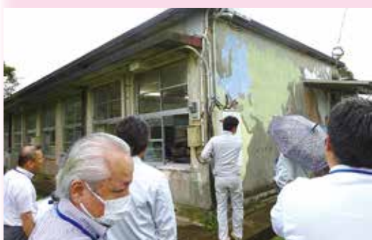
空調設置工事の現地調査の様子
