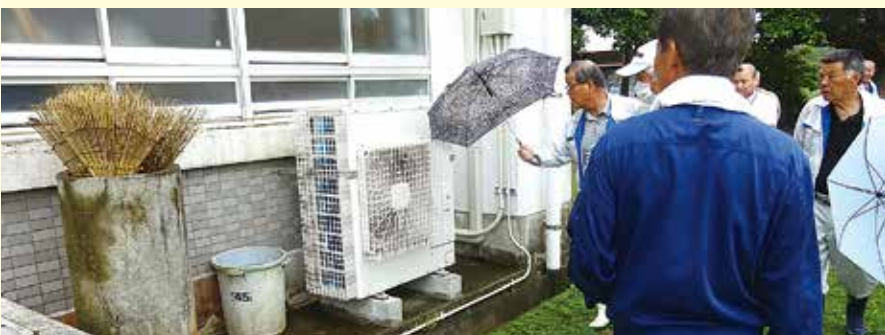
空調設置工事の現地調査のようす
