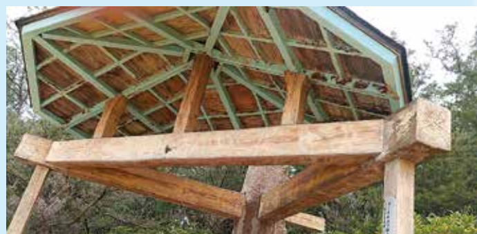
劣化により腐食が進む休憩所 (喜念浜)
