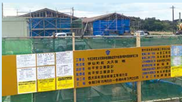
新築工事が進む西犬田布団地
