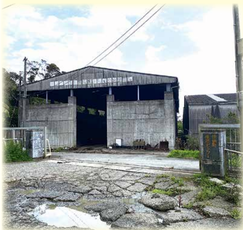
伊仙町堆肥センター (古里)
