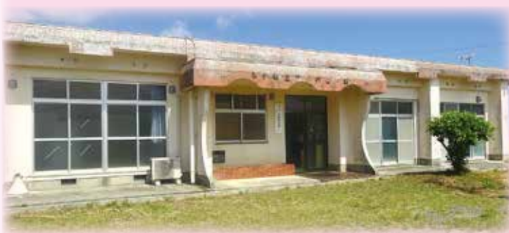
改修工事が行われた下検福生活館
