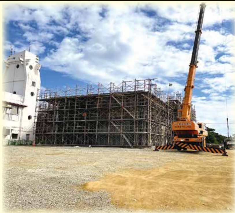
建築工事がすすむ役場新庁舎
