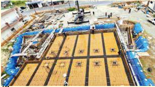
役場新庁舎新築二期本体工事のようす
