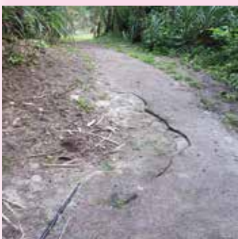
ひび割れた遊歩道(喜念浜)
