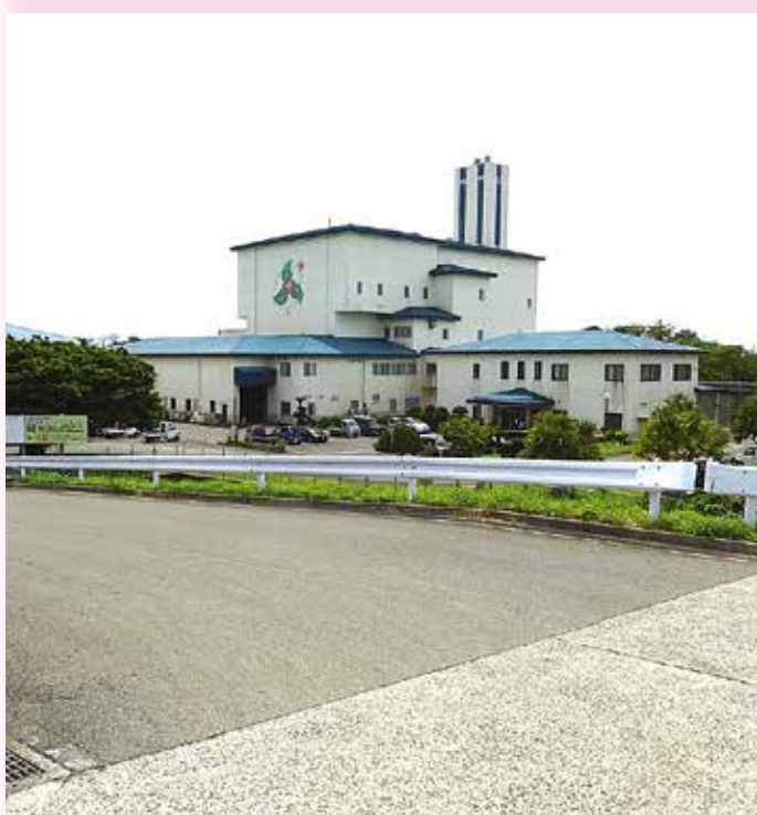
徳之島広域愛ランドクリーンセンター
