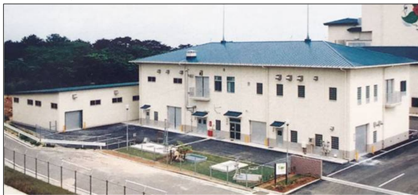
図 2-1-5 徳之島愛ランドクリーンセンター(最終処分場)
