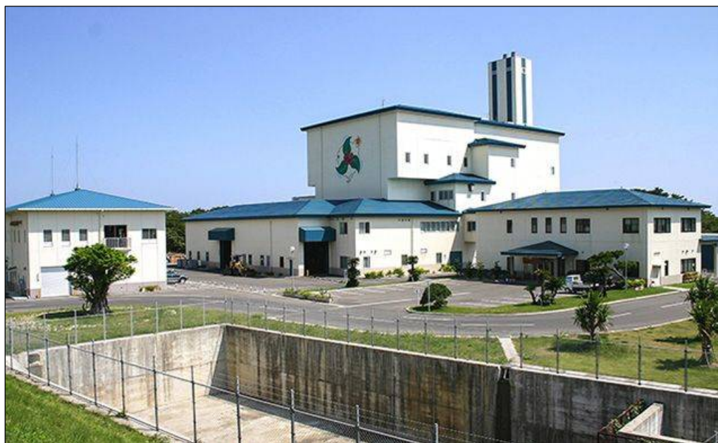
図 2-1-4 徳之島愛ランドクリーンセンター(ごみ処理施設、リサイクル施設)
