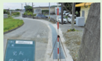
明眼線側溝布設
