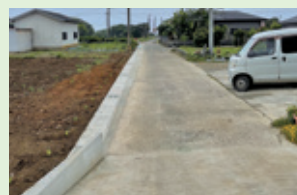
役場南側通路改良工事
