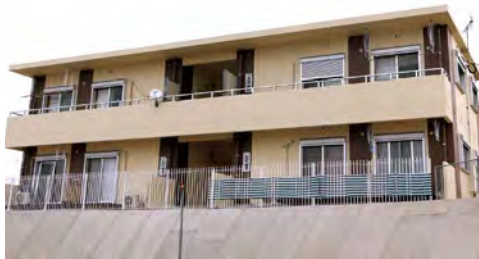
公営住宅の整備
