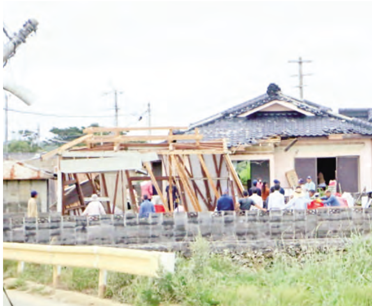
地域の方々による復旧作業
