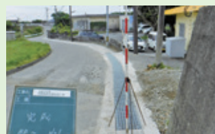
明眼線側溝布設
